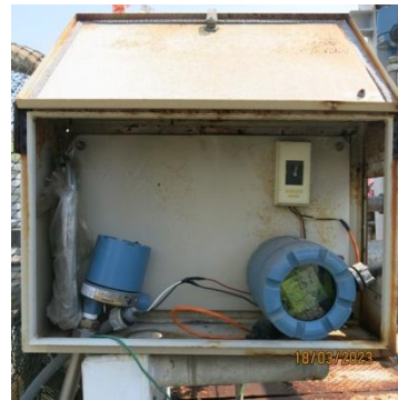
รูปที่ 6 pH Meter Online ที่บ่อปรับสภาพ ความเป็นกรด-ด่าง
