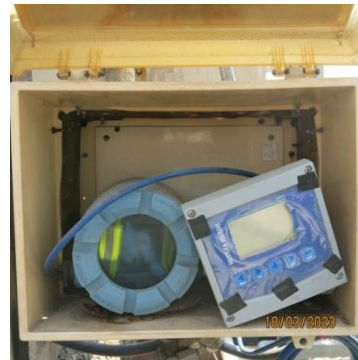
รูปที่ 4 pH-Temp. Meter Online ที่ Cooling Tower
